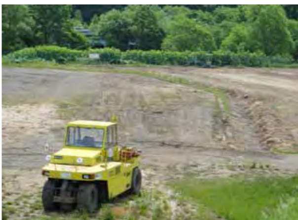
着工当時の旭川北都ソーラー発電所
